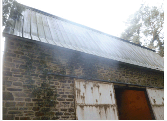
Composant : Plaques ondulées en toiture 1 (N) bac acier ensemble de la couverture
