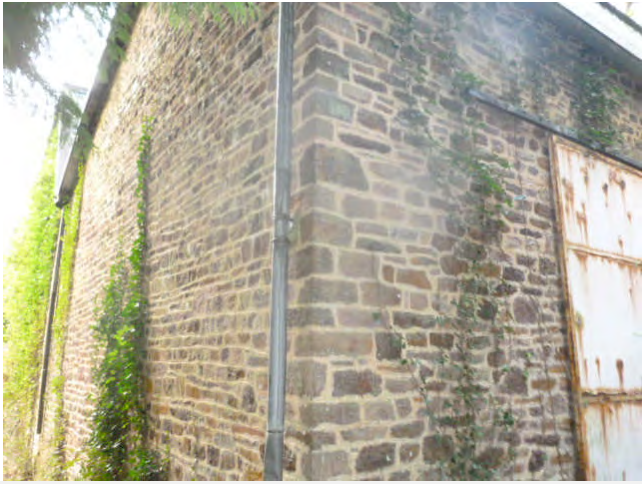
Composant : Conduit de fluide (eau) 2 (N) Dep zinc et fonte façades
